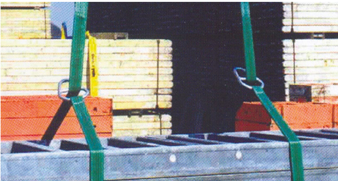
Bild 1-13: Sichere Auflage durch Beschlagteil
