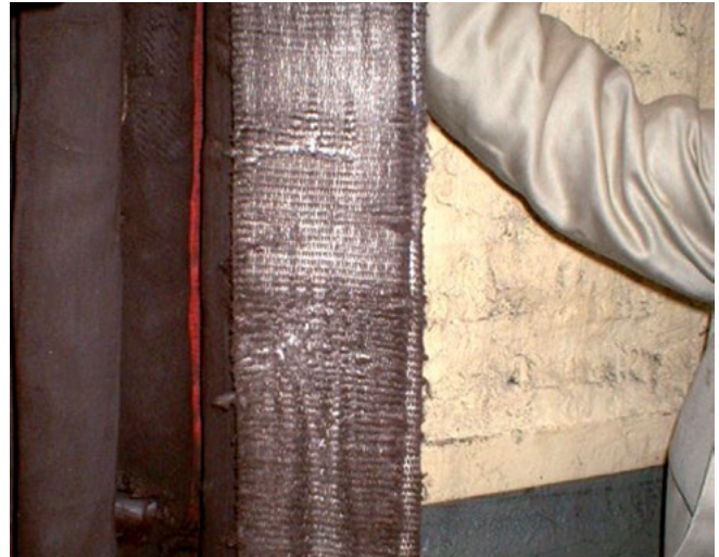
Bild 3-2: Prüfung durch einen Sachkundigen, Beispiel 2
